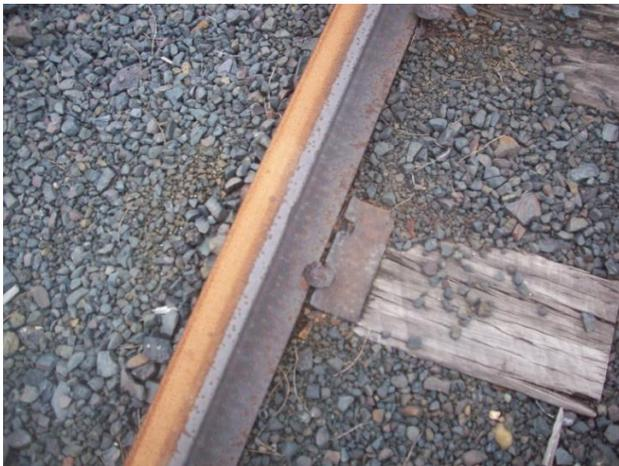
Figure 46 — Chemin de fer rouillé avec petites roches de couleurs plus foncées qu'ailleurs sur le site
