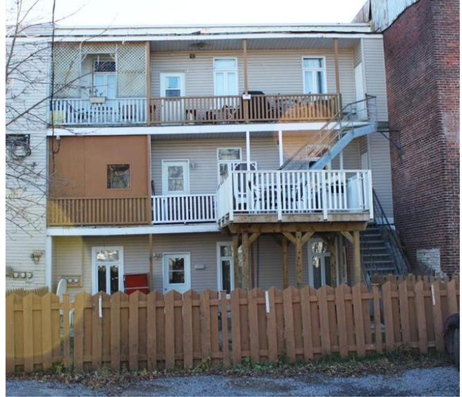
Figure 20: Panneaux et treillis de bois fixés aux balcons.
