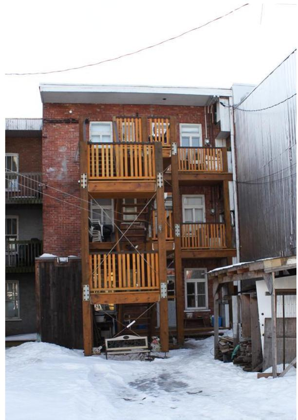
Figure 17 : Cicatrice apparente causée par la démolition de l'extension et nouvel escalier extérieur.
