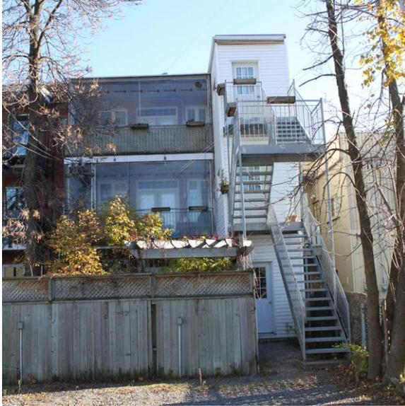
Figure 21: Extension rénovée, nouvel escalier extérieur et balcons fermés avec une pellicule de plastique.
