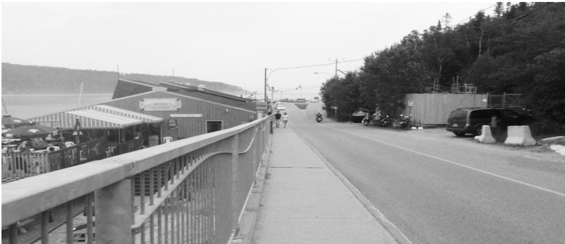
Figure 6 : Le quai de Tadoussac – Été 2010
