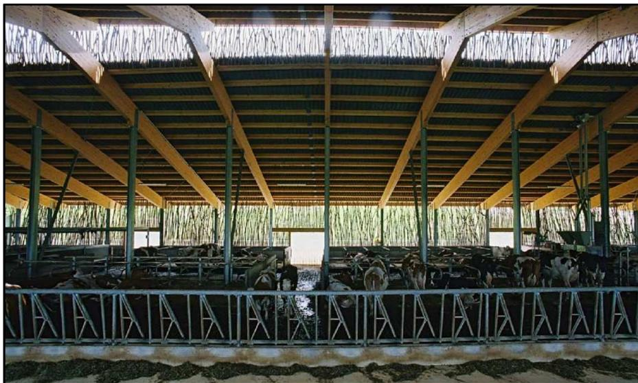
Figure 13: Mur et puits de lumière faits de branches (ferme laitière à Bâle) - source: [www.fab.ch](http://www.fab.ch)
