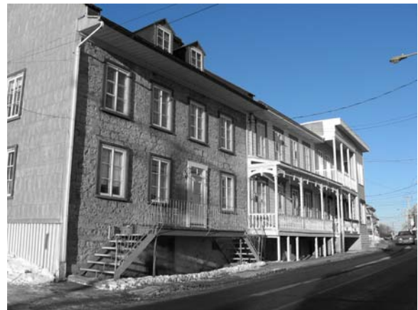
figure 15 : architecture traditionnelle source : auteur
