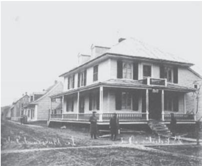
Figure 1.15 Galerie couverte avec balcon à l'étage
