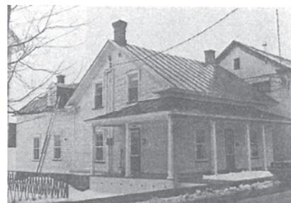
Figure 1.2 Annexe à l'arrière du corps de logis avec toit à pignon et lucarnes
