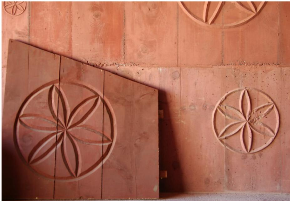
Fig. 28: Le coffrage fait office de négatif en contraste au mur
