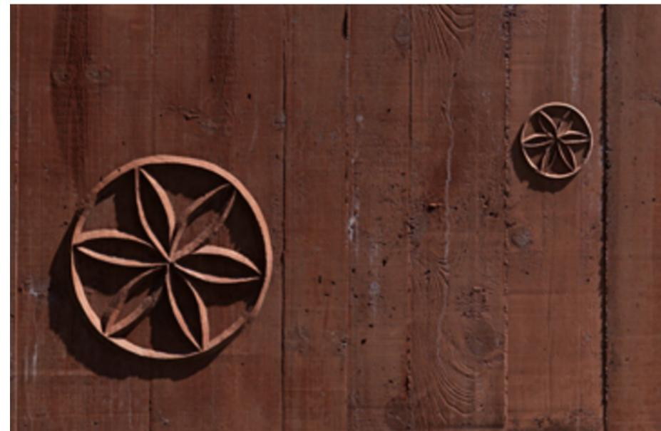
Fig. 24: Photo d'une surface de béton rouge-brun tatouée de rosettes
