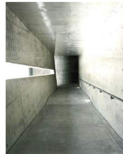
Passage autour de la cour triangulaire - Le percement permet de désolidariser le haut du mur de sa section basse
