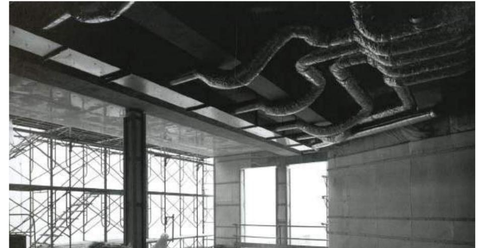
Cafétéria durant la construction - Les conduits mécaniques sont tous dissimulés dans le plafond
