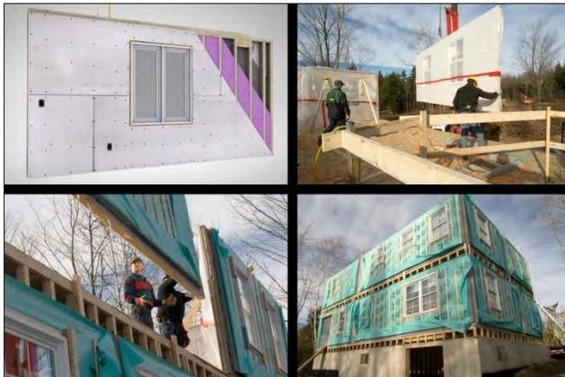
**Figure 6** Système à panneaux et assemblages
