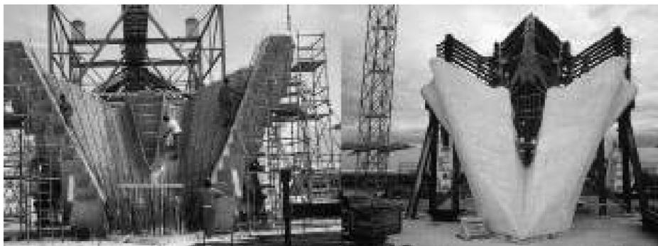
VUES DE L'APPUI PRINCIPAL EN BÉTON BLANC LORS DE LA CONSTRUCTION
