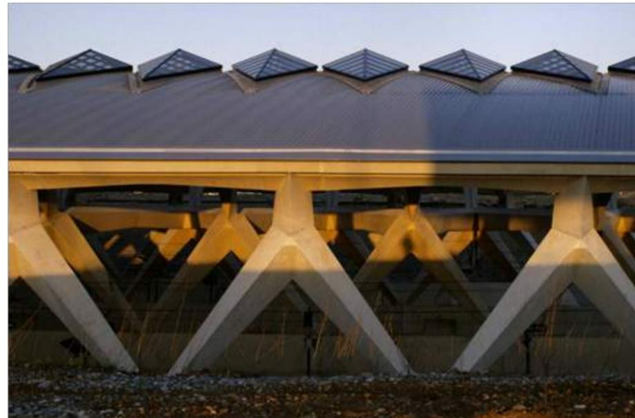
Au même titre, l'utilisation de poutres en zigzag qui relient les colonnes inclinées de la zone d'embarquement engendrent cette impression de mouvement par la connexion des éléments en quinconces. Cela crée une continuité entre eux et une incitation au déplacement par rapport à des poutres qui auraient été perpendiculaires aux voies ferrées et discontinues entre elles. Comme l'explique Copains : « Un esprit à la recherche du mouvement, une tentative de suspendre le temps. »
