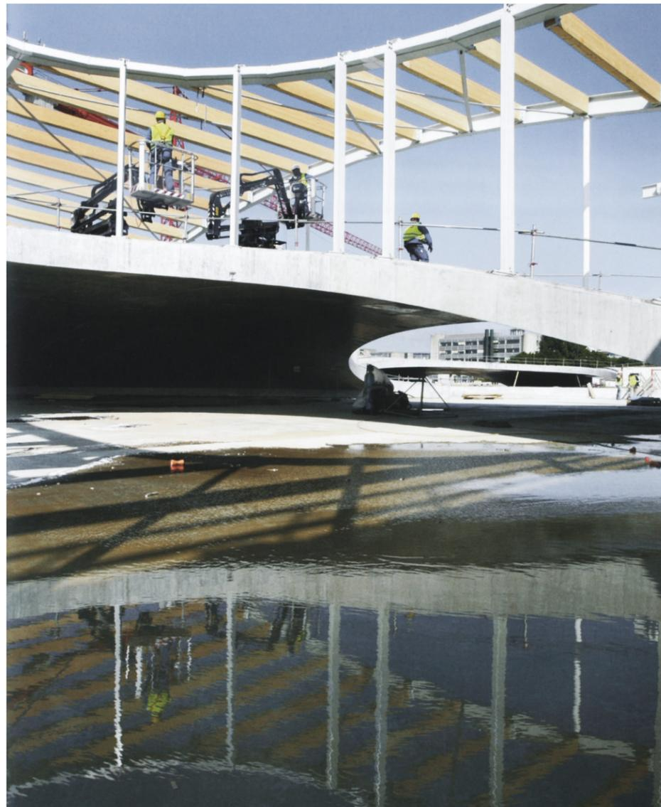
Image 21: Structure de plancher en béton, structure de toiture en bois et acier
