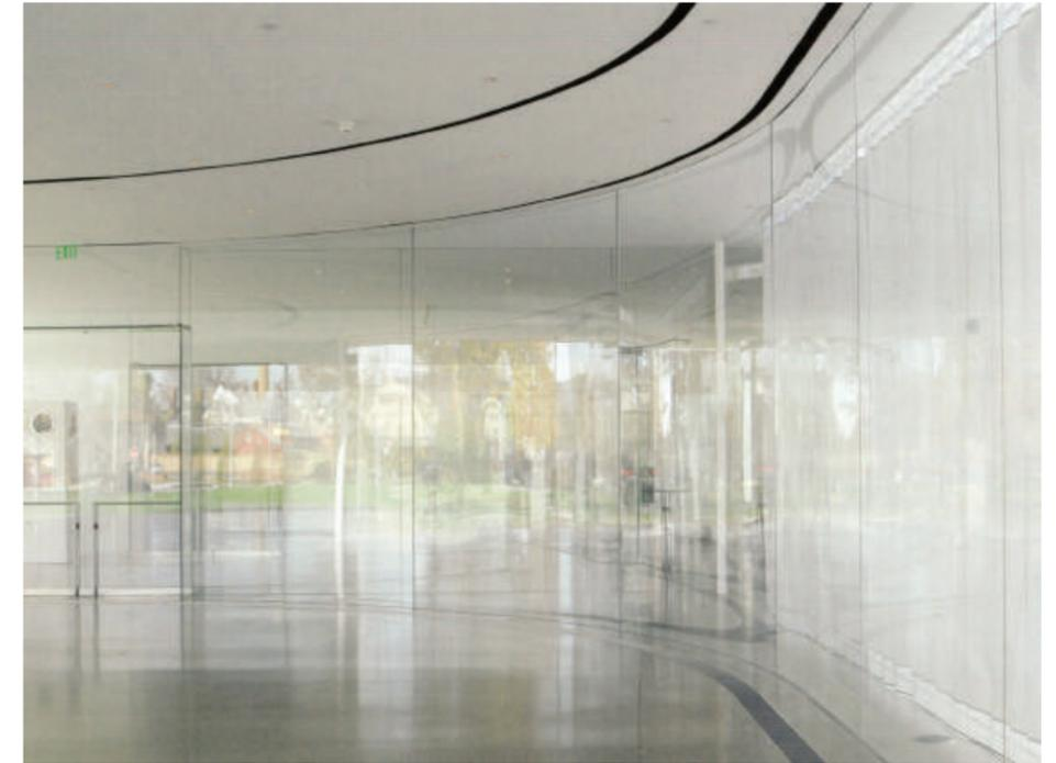
spécial, produisant une apparence semblable à celle du terrazzo. Puisque la position du verre est encastrée dans le plancher de béton et que sa fabrication est réalisée à l'étranger, la précision entre l'usine et le chantier doit donc être impeccable.
