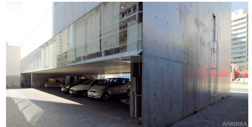
Stationnement et espace public sous la galerie http://www.arkinka.net/ark_article.php?idart=3344&idedi=153
