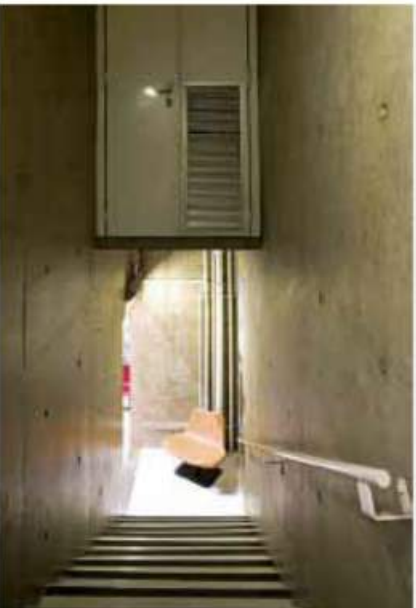
intérieur d'un contrefort, espace servant, Finotti, 2009)
