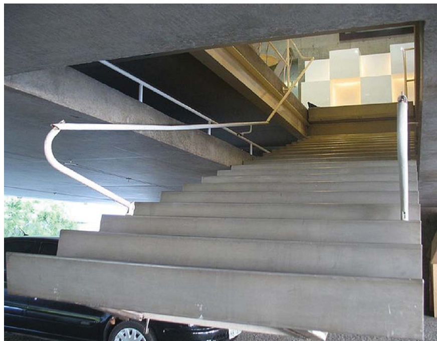
Détail de l'escalier
