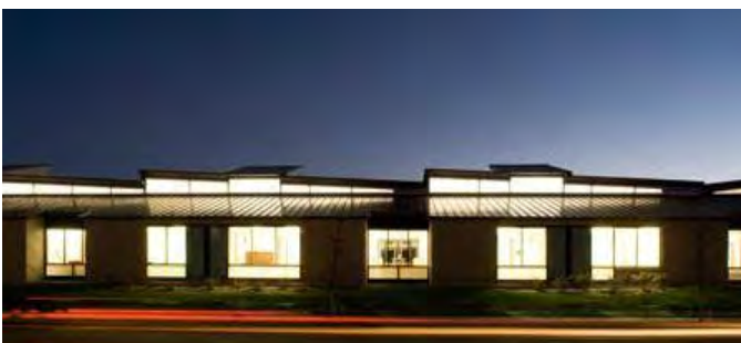
Élévation du bâtiment avec puits de lumière apparents
