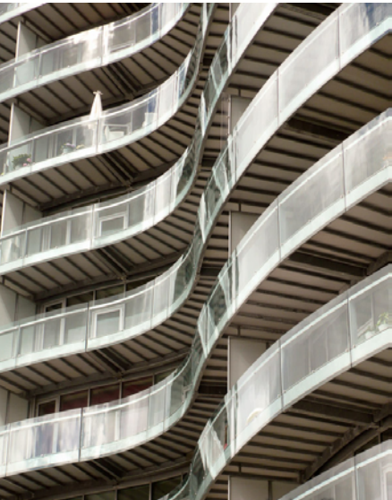
Fig. 21: Motif de la façade avec éléments de structure apparents, source: Evan Charkoff
