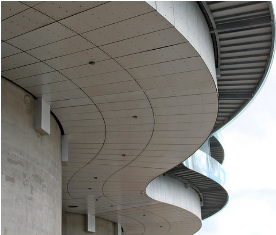
Fig. 47: Vue du dessous du plancher du premier étage, en évidence le revêtement en plaques d'alliage d'aluminium avec luminaires encastrés. Source: Flickr
