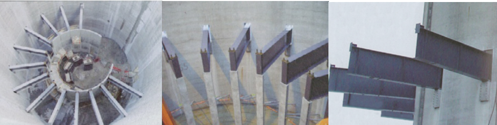
Fig.33: À l'intérieur d'un silo, positionnement des poutres principales en acier Fig.34: À l'intérieur d'un silo, connexion avec les poteaux en tension Fig.35: À l'extérieur d'un silo, poutres principales en attente de la construction des appartements., source: KM3- Excursions on capacities.
