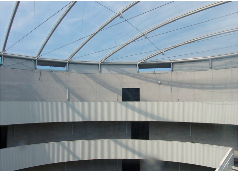
Fig. 42: Vue d'une des toitures en Texlon, avec en évidence les ouvertures de ventilation, arches de soutien et fils de tension, Source: Flickr.com, Photographie: Proxecto d'habitat
