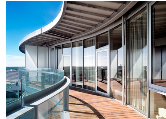
Fig. 51: Balcon extérieur, en évidence la toiture avec structure laissée apparente, la façade en vitrage et aluminium de marque Shuco, le garde-corps vitré fixé sur une structure d'acier et la finition supérieure en bois., source: mvrdiv.nl
