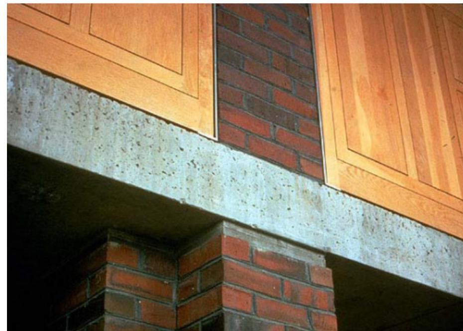
Image 5 - Jonction de béton, brique et bois.
