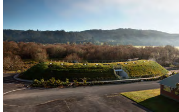
Figure 28: Exemple de toiture végétalisée et de mur masse, Te Mirumiru (source: http://www.archdaily.com )
