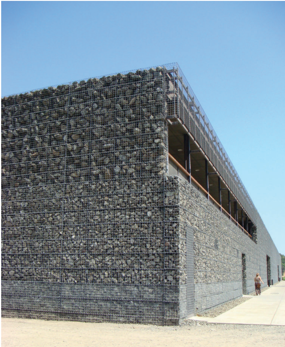
photo 19: Différenciation des gabions.
