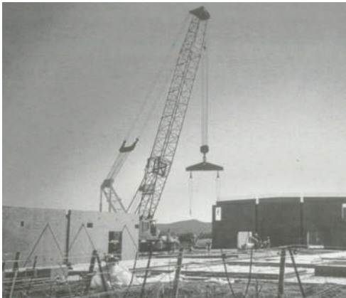
photo 24: Montage de la structure.
