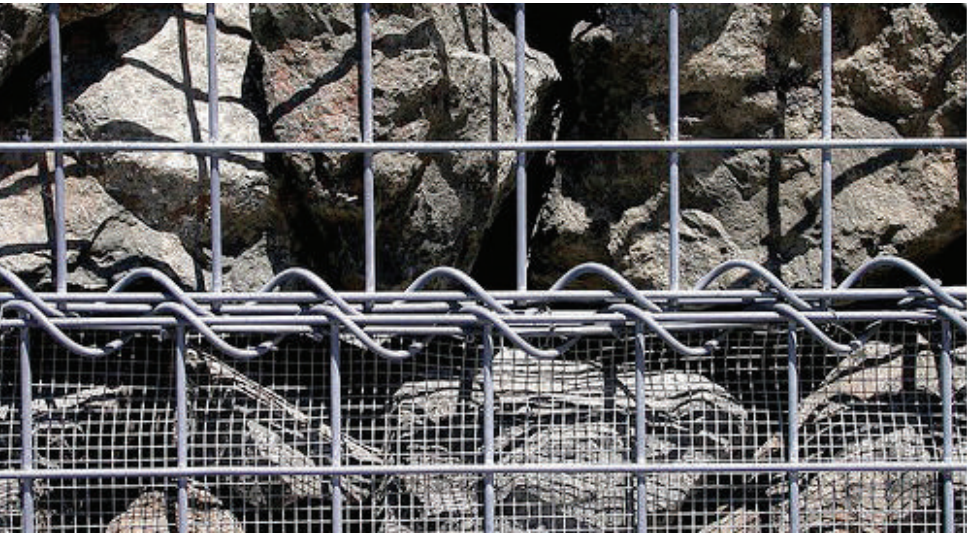
photo 17: Fils d'acier galvanisé entortillés et posés manuellement.
