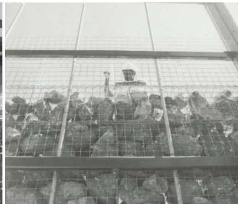
photo 21: Empilement de basalte lors de la construction.
