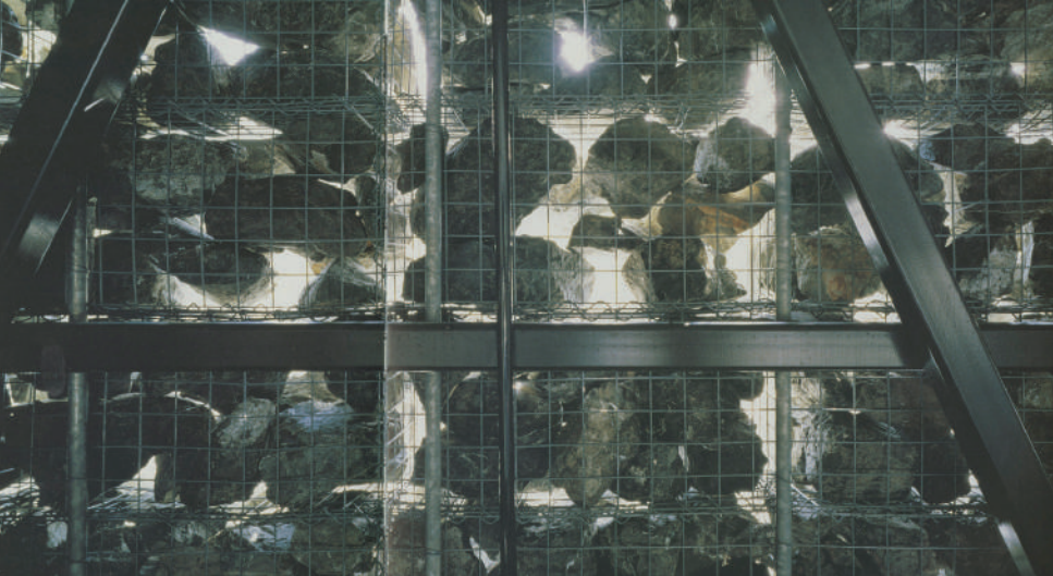
photo 18: Structure d'acier et éléments anti-sismique.
