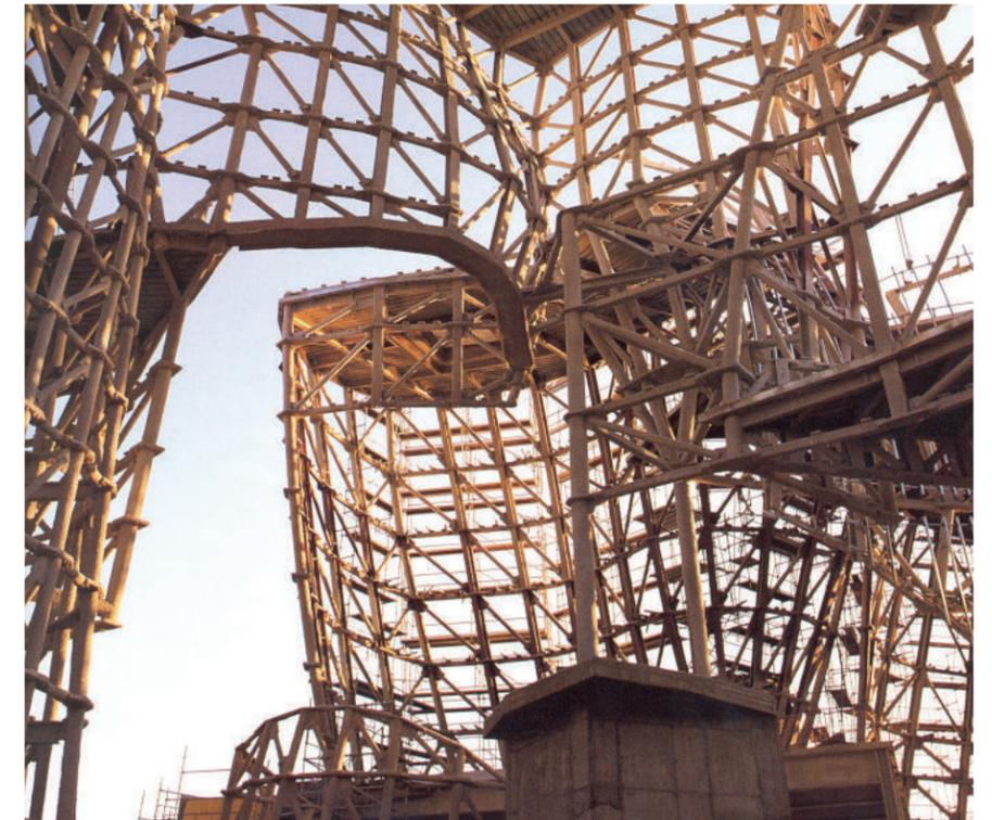
Figure 31. Structure d'acier érigée lors de la construction du musée, VAN BRUGGEN, Coosje, 1999, p.159
