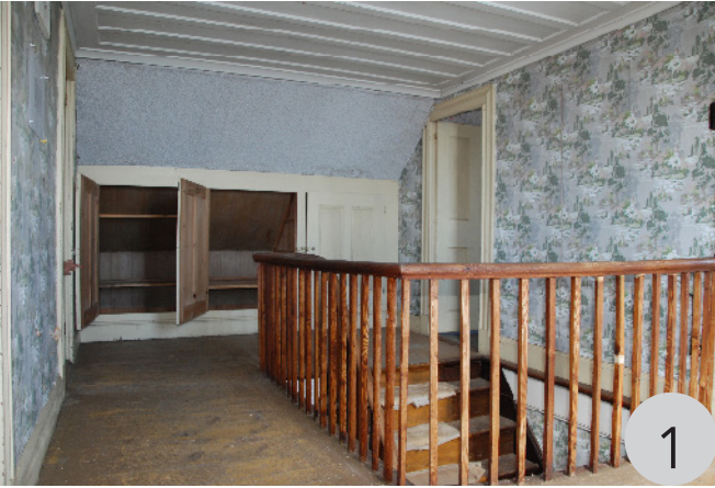
Des armoires ont été rajoutées pour optimiser l'espace conféré par la pente du toit face à l'escalier.
