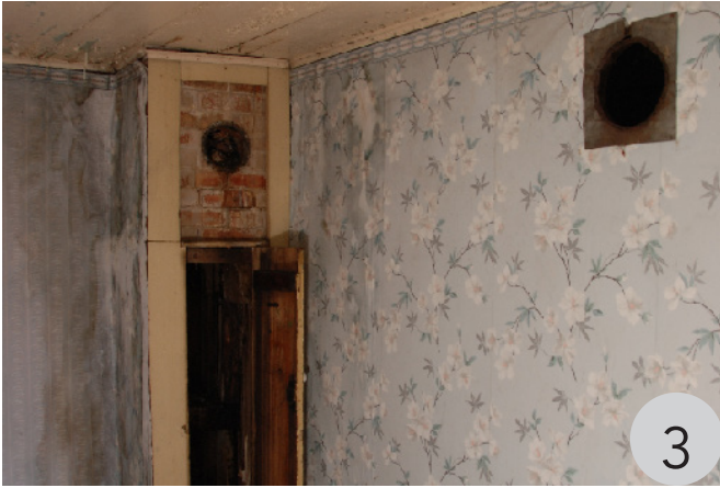
À partir du rez-de-chaussée, le tuyau du poêle serpentait entre les pièces pour diffuser la chaleur.
