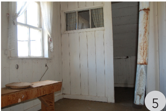
Une toilette sèche était aménagée dans l'annexe. L'évent d'évacuation était raccordé à la cheminée.
