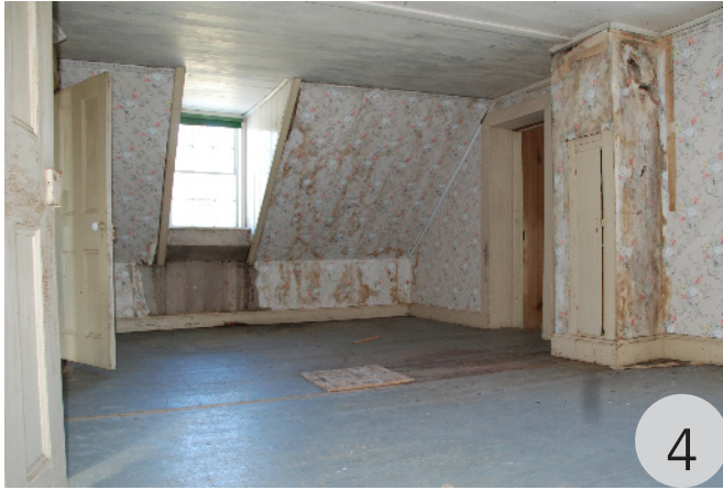
Le plancher et le plafond dévoilent le retrait de la cloison qui divisait la pièce. Le tuyau du poêle a été retiré. La partie inférieure de la cheminée a été convertie en armoire.
