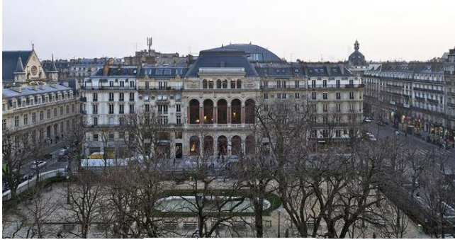
Figure 20: Façade principale de la Gaîté Lyrique, Paris
