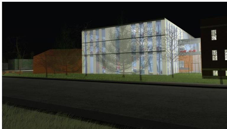
Figure 25 – Perspective | façade en « Profilite », alternance de verre givré et clair (Dubreuil 2012)
