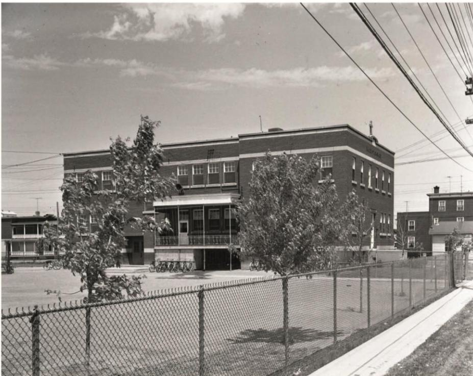
Un nouveau balcon couvert a été ajouté au 1er étage, et une fenêtre a été remplacée par une porte.
