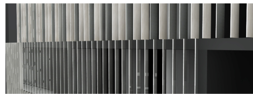
Les lattes amovibles filtrent la lumière, animent la façade et s'ajustent par les usagers
