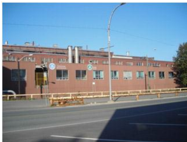
Figures 4 et 5 : L'usine en cours de démantèlement
