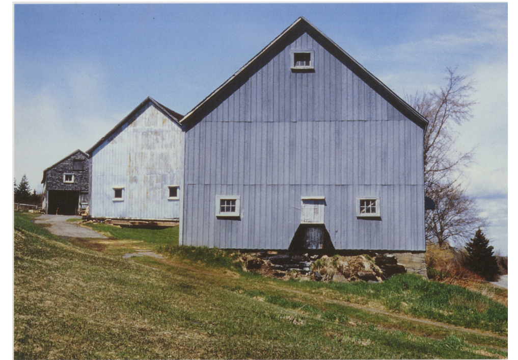
▲ Vernaculaire, revêtement de bois et fondation - NE
