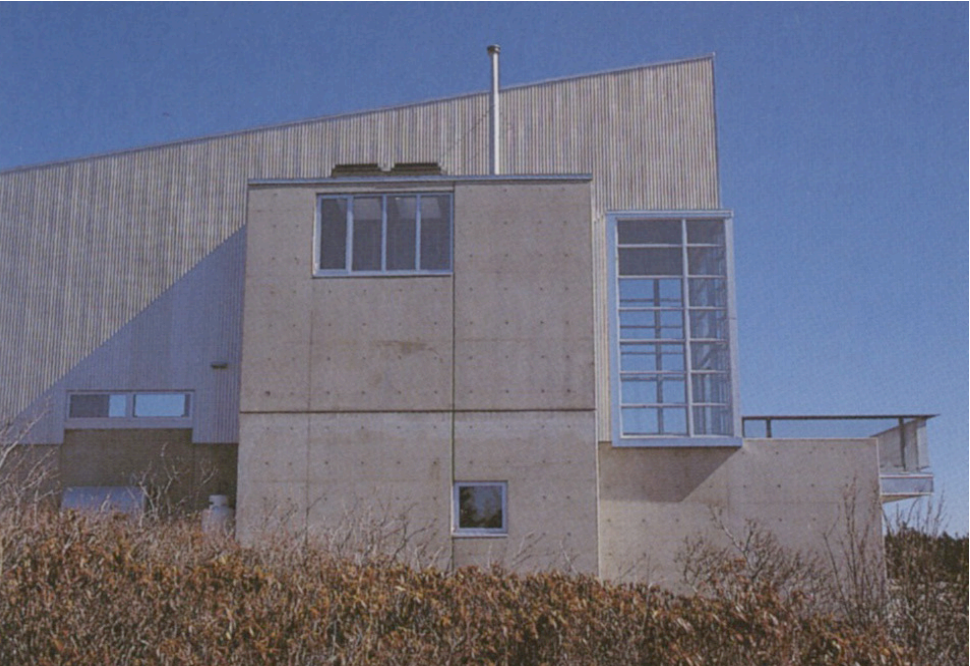
Vue de la saillie en béton coffré et jeu de textures avec le revêtement métallique. ▲ impressionnantes avec l'eau avoisinante. Par souci de cohésion architecturale, les portes coulissantes refermant la cour intérieure ont été recouvertes de ce matériau polyvalent, ce qui contribue d'ailleurs à l'effet de masse que le bâtiment procure. De plus, tout comme les murs de la Howard House, la toiture, exprimée comme la cinquième façade du projet en quelque sorte est aussi en tôle ondulée, ce qui permet d'avoir une seule et unique matérialité sur l'ensemble de l'extérieur.
