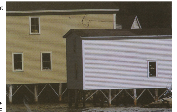
► Vernaculaire, pilotis - NE
