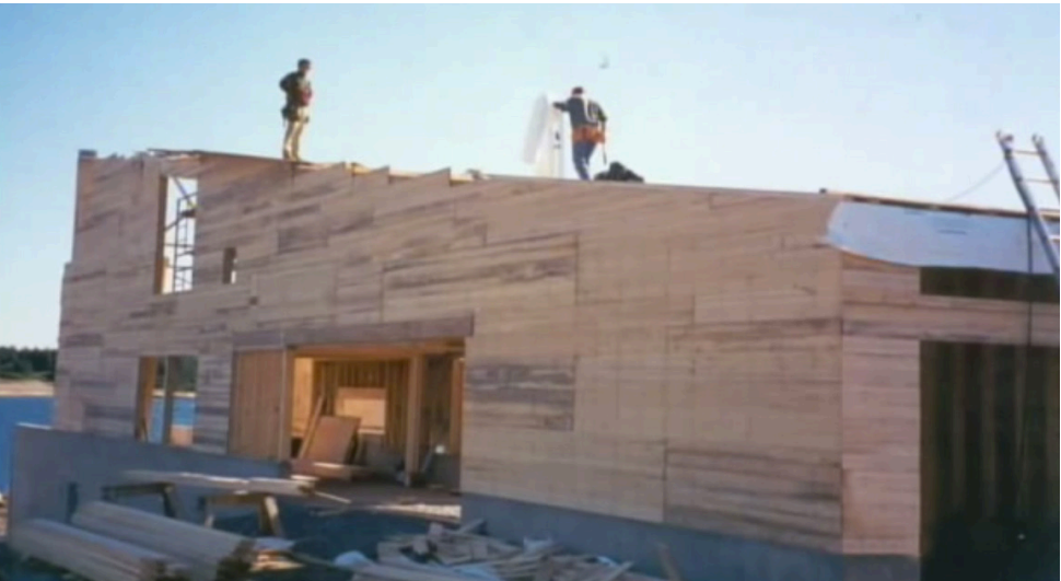
Construction du revêtement intra mural au moyen de planches de bois horizontales. ▲
