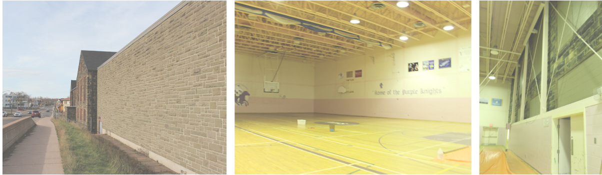
Figure 30 : Gymnase actuel (photos par l'auteure) Image 1 : Façade sur chemin Mountain | Images 2 et 3 : Intérieur du gymnase
