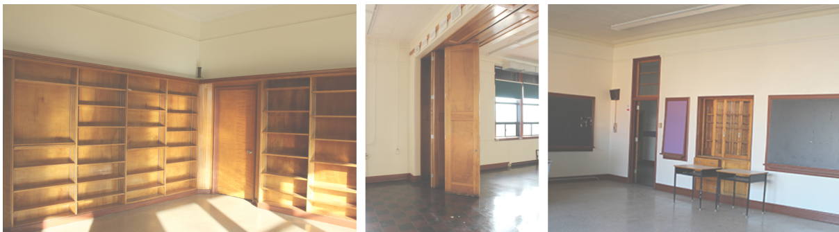
Figure 31 : Éléments à récupérer des ailes de salles de classe (photos par l'auteure) Image 1 : Bibliothèque | Image 2 : Portes pliantes | Image 3 : Porte et armoire de salle de classe
