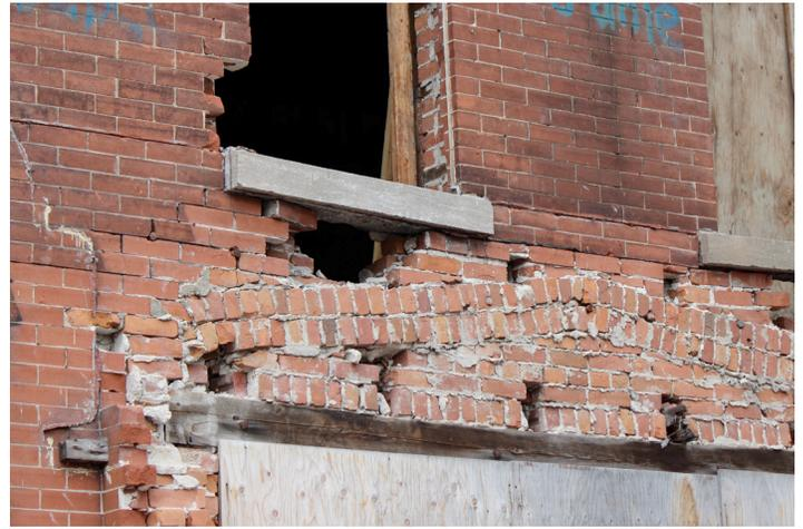
Affaissement du mur arrière en raison de la large ouverture
