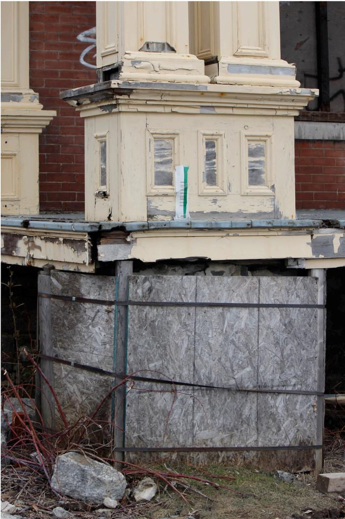
Pilier de pierre et portion du balcon avant en mauvais état
