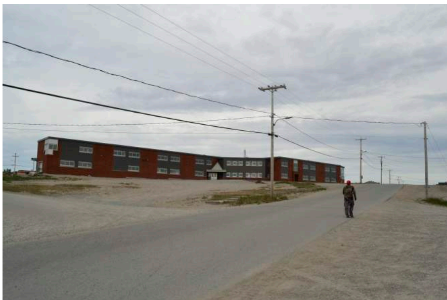
L'école existante et le site d'intervention, photo par M. Rochette
