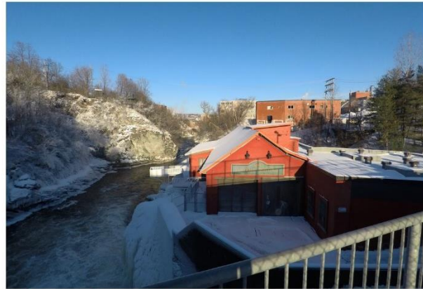
vue du barrage de la centrale Frontenac
