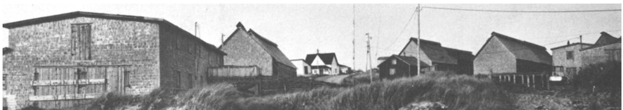
Figure 34 : Ancien ensemble de bâtiments de pêche, Pointe basse
